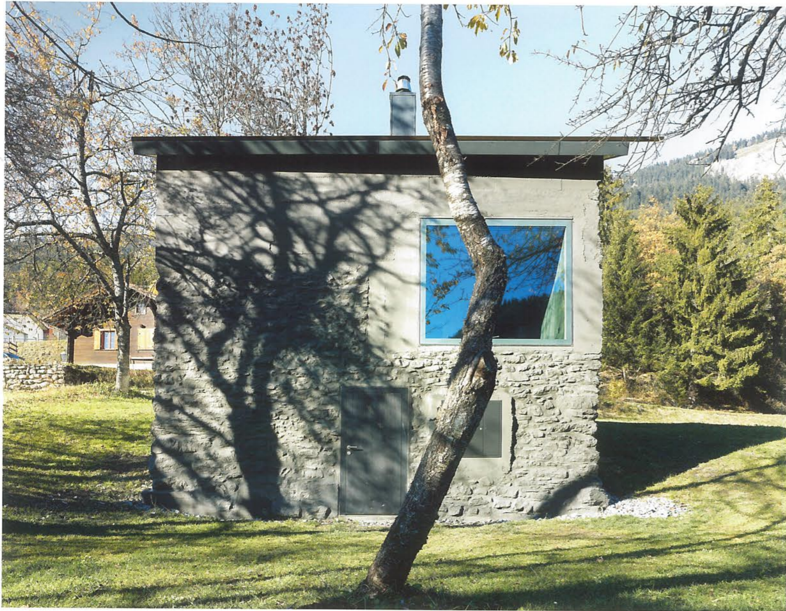
7 Den Dachüberstand hätte Laurent Savioz am liebsten weglassen, um die monolithische Gebäudeform noch mehr zu betonen.
