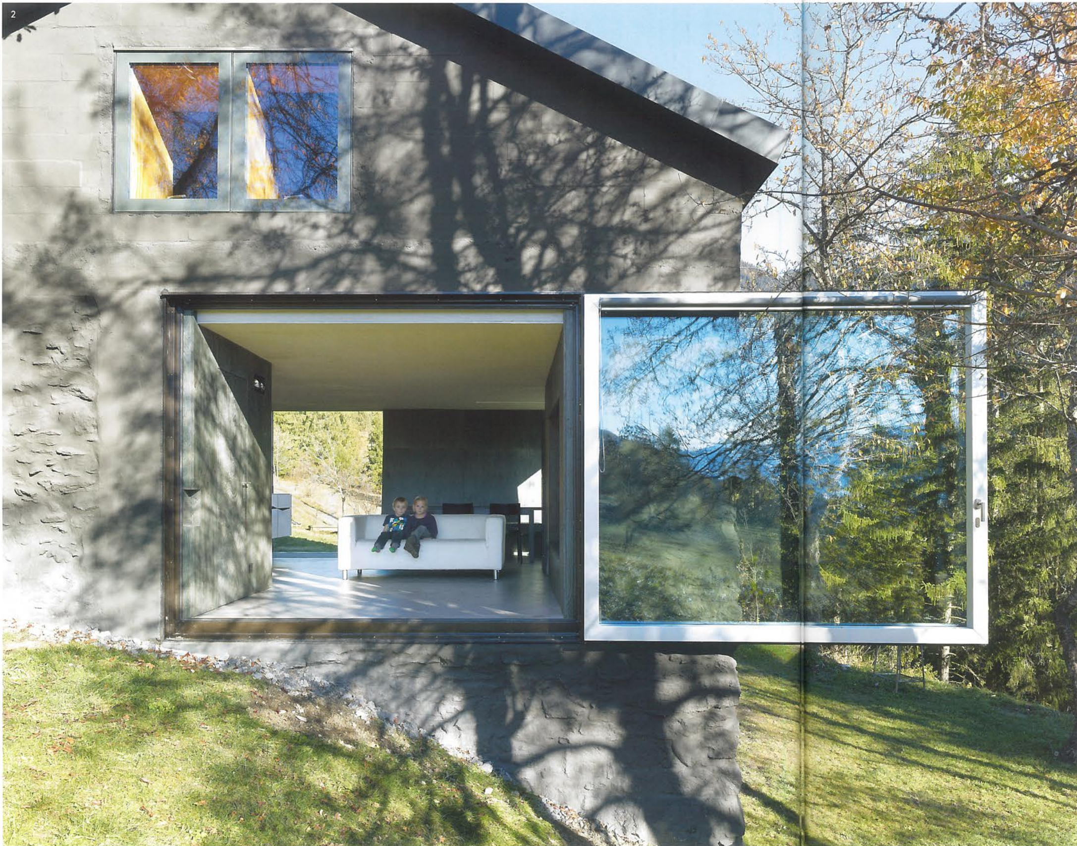
2 Das grosse Fenster mit Blick dem Rhonetal entlang ist rund 700 Kilo schwer. Sechs grosse Scharniere ermöglichen die komplette Öffnung des Flügels nach aussen.
