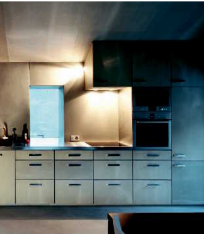
Des panneaux en aggloméré de ciment habillent cette cuisine, dessinée sur mesure. THOMAS JANTSCHER
