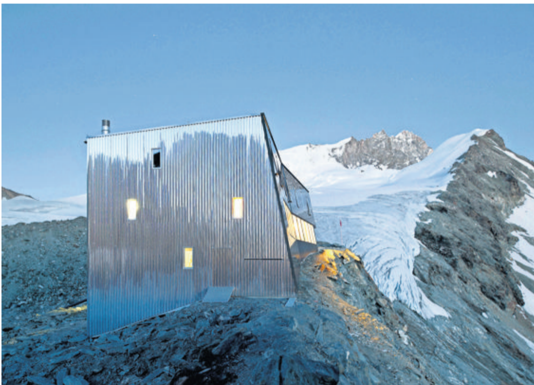
Tracuit, Zinal La nouvelle cabane de Tracuit (3256 mètres d'altitude) s'étire sur l'arête rocheuse. Sa façade vitrée prolonge la verticalité de la falaise. Selon la lumière et les conditions météo, l'inox qui recouvre le refuge permet à la cabane de se fondre dans le paysage.
