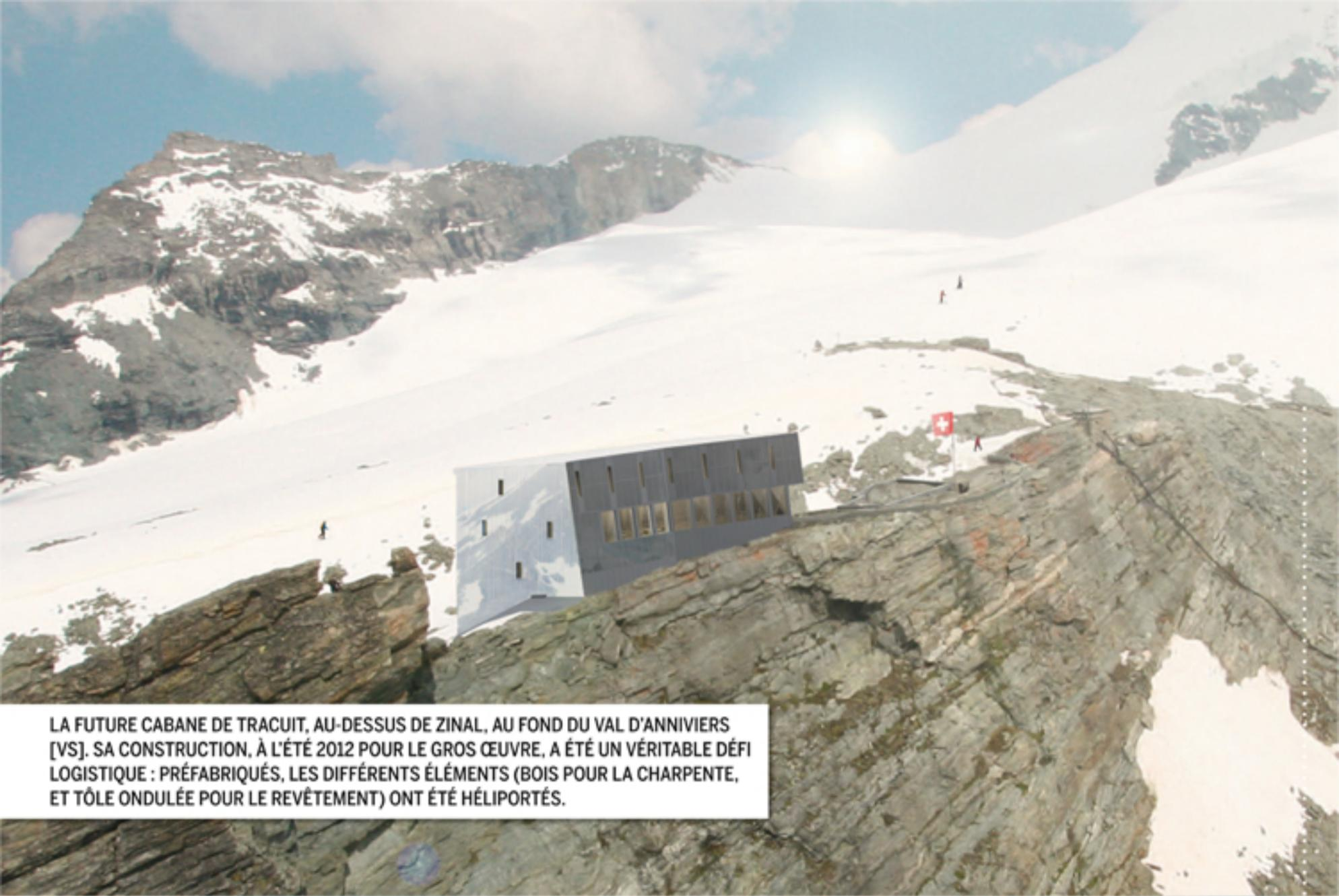
LA FUTURE CABANE DE TRACUIT, AU-DESSUS DE ZINAL, AU FOND DU VAL D'ANNIVIERS [VS]. SA CONSTRUCTION, À L'ÉTÉ 2012 POUR LE GROS ŒUVRE, A ÉTÉ UN VÉRITABLE DÉFI LOGISTIQUE : PRÉFABRIQUÉS, LES DIFFÉRENTS ÉLÉMENTS (BOIS POUR LA CHARPENTE, ET TÔLE ONDULÉE POUR LE REVÊTEMENT) ONT ÉTÉ HÉLIPORTÉS.
