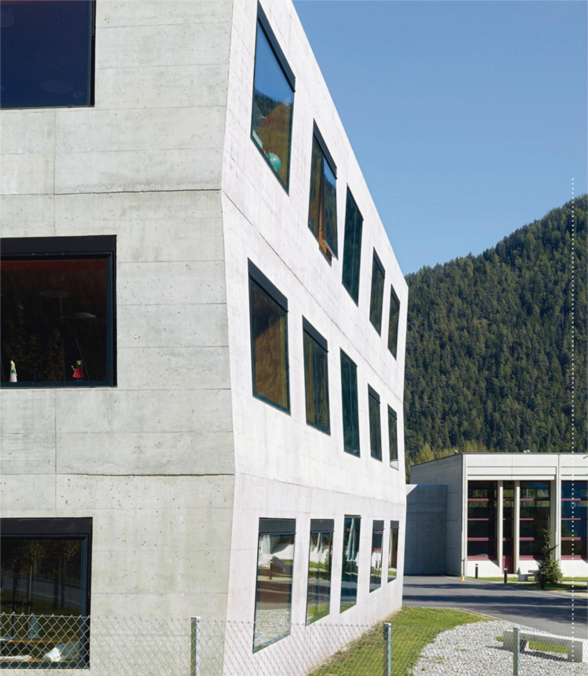
ECOLE PRIMAIRE À VOLLÈGES, DÉTAIL DE LA FAÇADE. LE TRAVAIL DU BÉTON EN FACETTES PERMET DE ROMPRE AVEC LA MONOTONIE HABITUELLE DE CE MATÉRIAU. « QUI EST, EN FAIT, BEAUCOUP PLUS PLASTIQUE ET MALLÉABLE QUE L'ON IMAGINE », DISENT LES ARCHITECTES.
