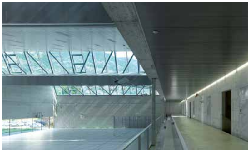
VUE DES GRADINS SUR SALLES DE SPORT ET FENÊTRES DE TOITURE | DIE SPORTHALLEN VON DEN TRIBÜNEN AUS GESEHEN, BLICK AUF DIE DACHFENSTER
